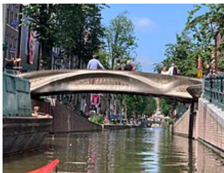
Рис.1.3 Stoofbrug в Амстердамі, перший в світі 3D-надрукований металевий міст
