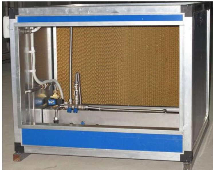
Рис.4.5. Випарний зволожувач
