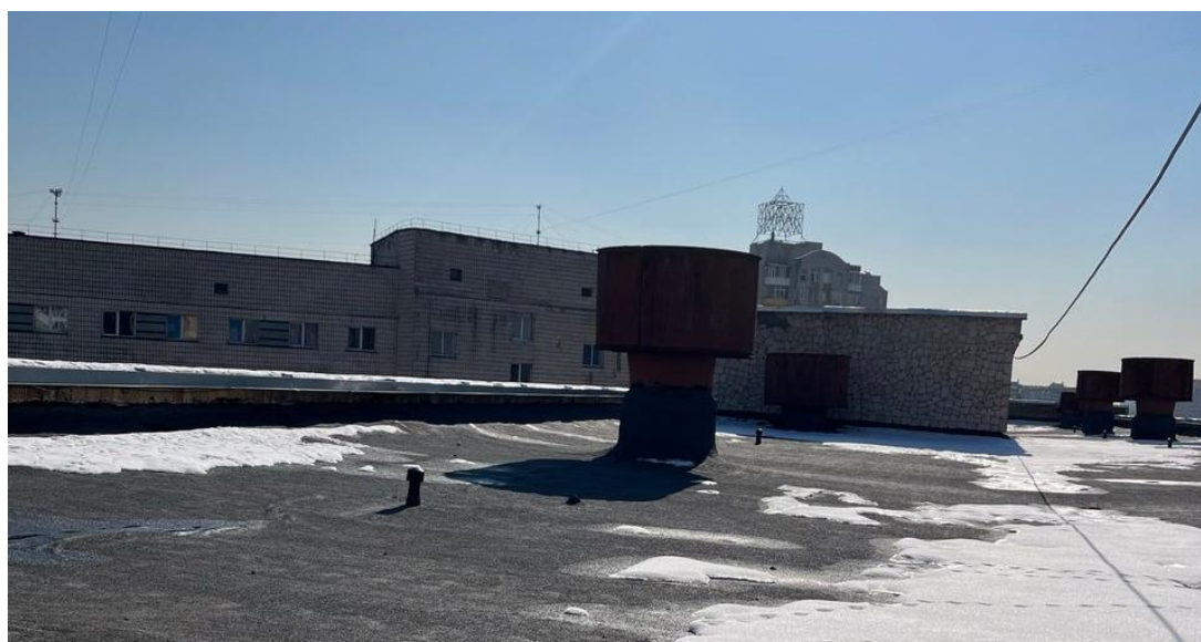
Рисунок 1.5 – Вентиляційні виходи на даху будівлі
