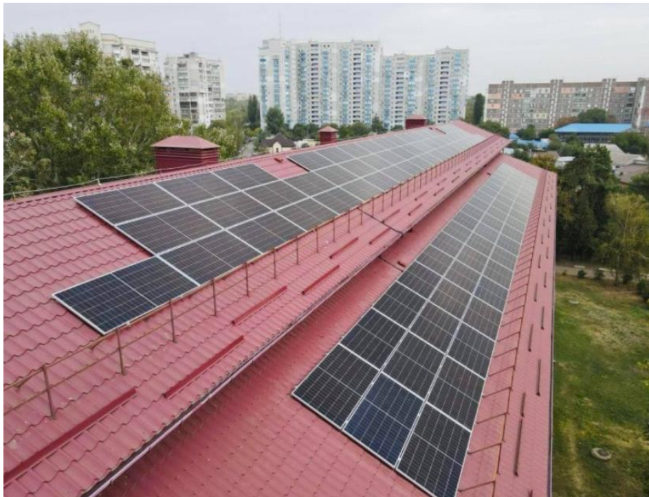
Рисунок 1.1 - Сонячні панелі на скатному даху.
