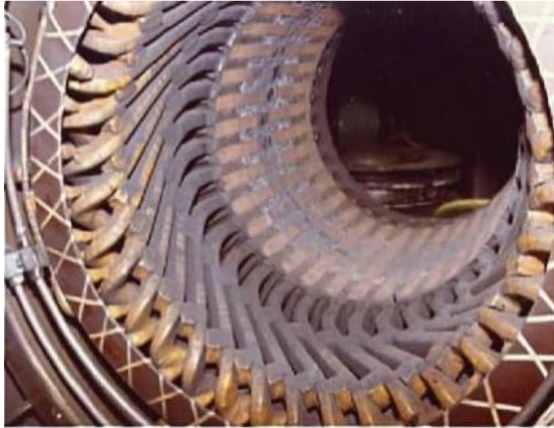
Рисунок 1.8 – перегрів статора СГ [8]
