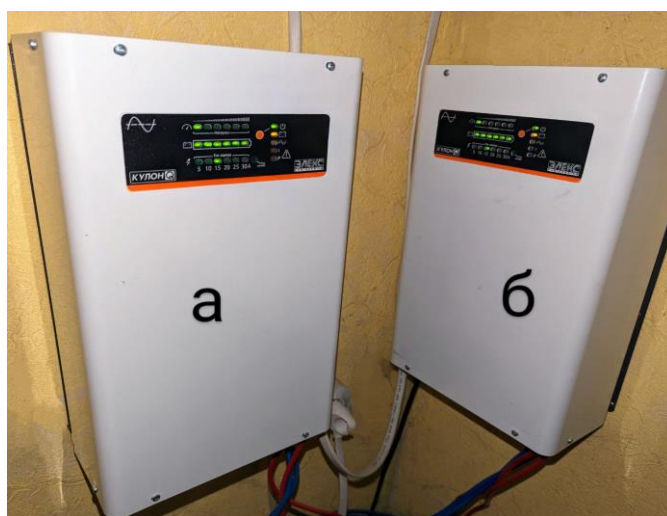
Рис.3.3. ДБЖ а режимі інвертора, робота від АКБ а)150Ah(GEL) та б)150Ah(AGM).Об'єкт 1
