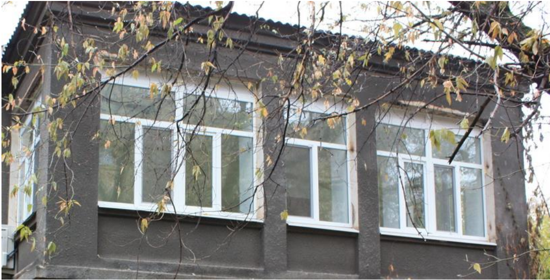
Рисунок 2.6 – Зовнішні вигляд віконних конструкцій
