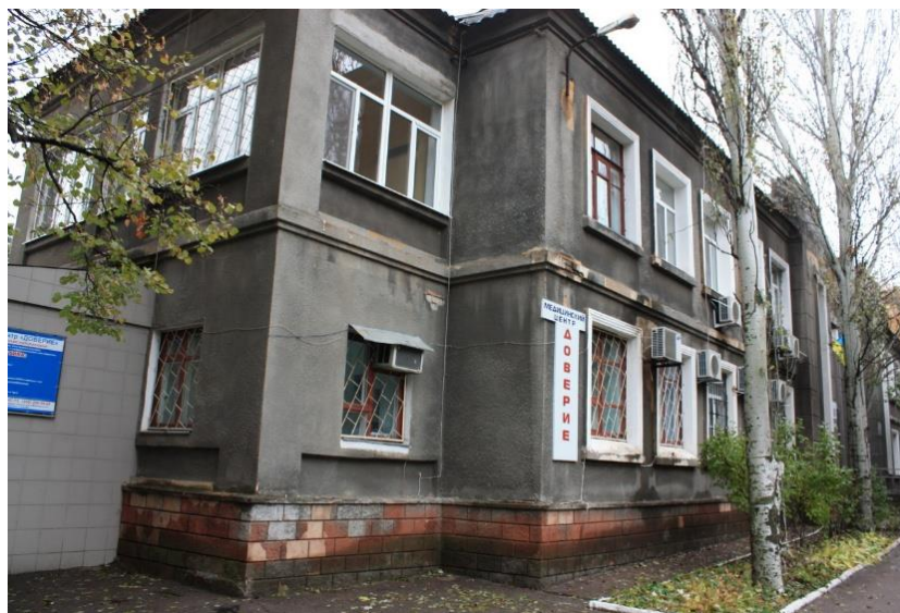
Рисунок 2.5 – Зовнішній вигляд фасаду
