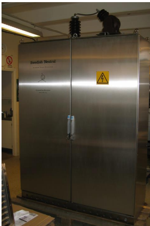
Рис. 1.2 – Суцільний резистор внутрішнього встановлення, набраний зі сталевих резистивних елементів
