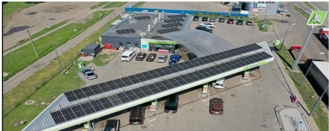
Рисунок 1.3 Сонячні станції на фасаді підприємства
