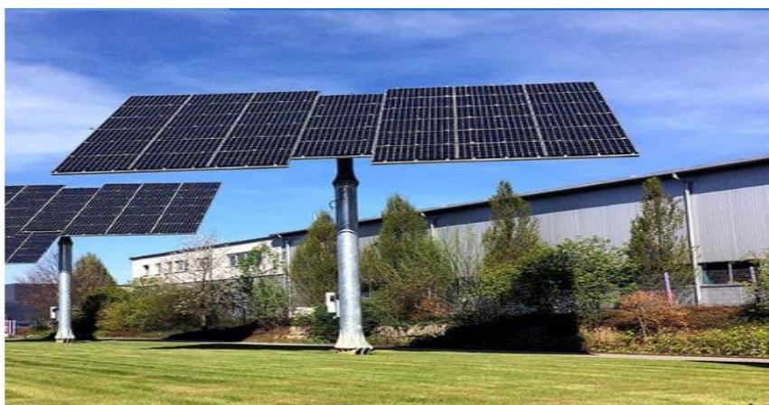
Рисунок 1.2 Зображення Сонячної станції на трекері
