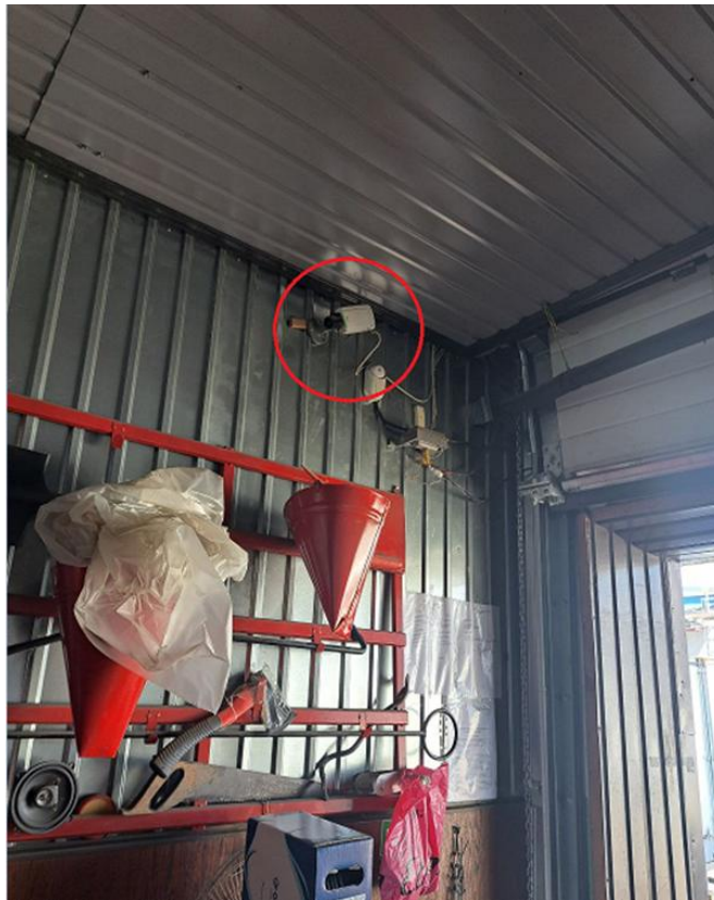
Рисунок 2.4 - Камера в 1 будівлі під заміну
