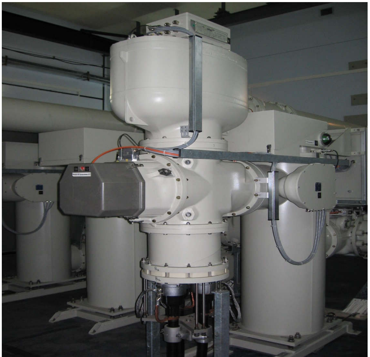
Рисунок 2.6 – Пружинно-гідравлічний привод КРПЕ
