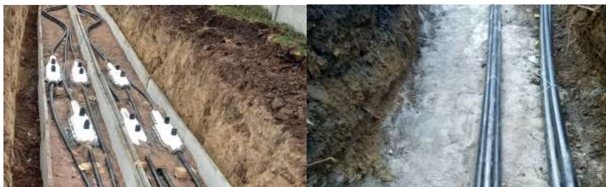
Рисунок 22 – Особливості прокладання кабельної лінії 110 кВ ПС «Фурси» - ПС «Рось» [31]
