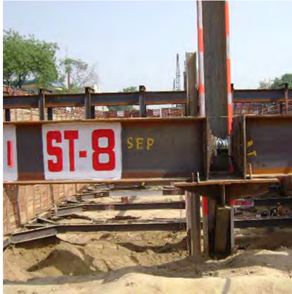
Рисунок 2.2.1.1 - Датчик навантаження на стиснення між стійками на станції метро, що будується
