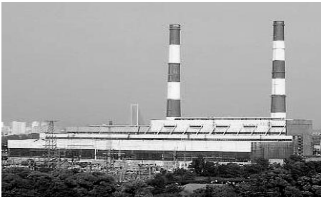
Рисунок 3.1. Загальний вигляд ТЕЦ-5
