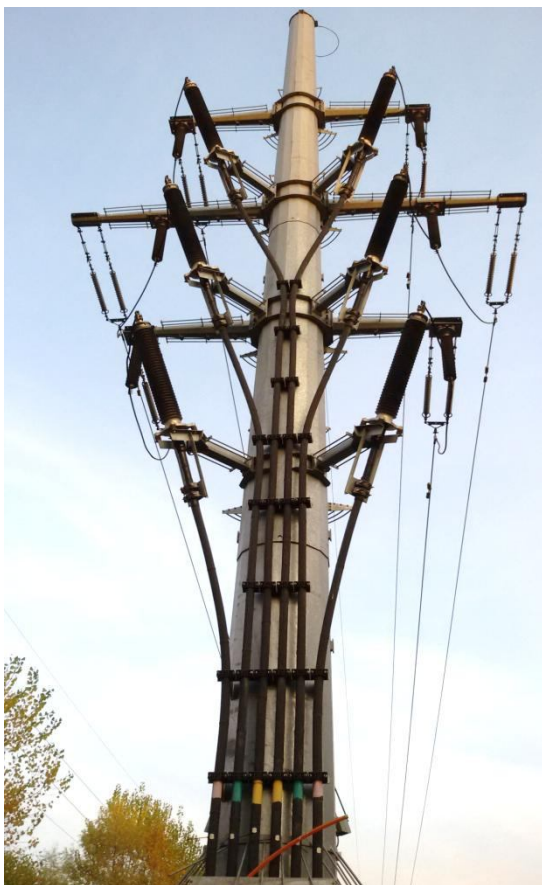
Рис. 1.70. Кабельні муфти: a – перехідні (кінцеві) різних класів напруги; б – перехідні з кабельної до ПЛ напругою 110 кВ (вигляд вздовж траси); в – перехідні з кабельної до ПЛ напругою 110 кВ (вигляд перпендикулярно трасі)
