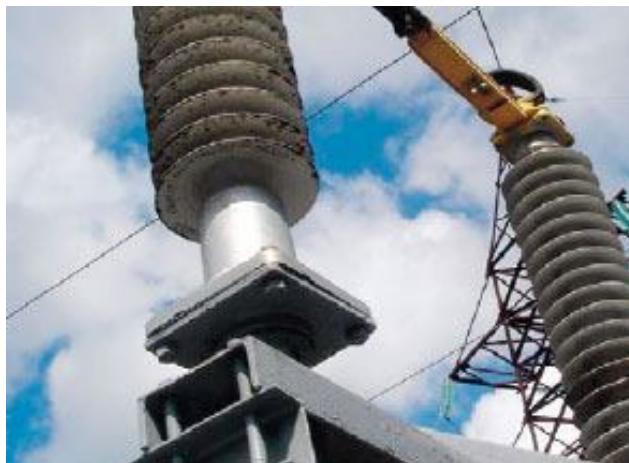
Рис. 1.52. Ізолятор, покритий колоніями грибків
