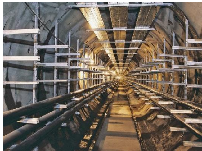
Рис. 1.76. Розміщення кабелів та трубопроводів у круглому каналі: а – ескіз розрізу каналу; б – вигляд у натурі
