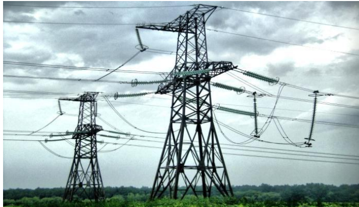
Рис. 1.32. Транспозиція на ПЛЕП: а – схема повного циклу по довжині лінії l = l_1 + l_2 + l_3 ; б – транспозиційні опори ЛЕП 330 кВ
