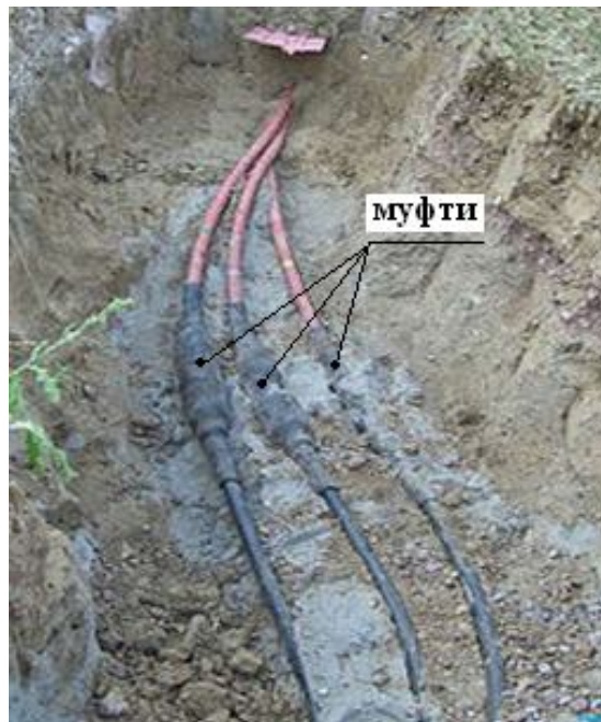
Рис. 1.62. Кабельні з'єднувальні муфти
