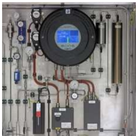
Рис. 1.7. Зовнішній вигляд комплексу вологоміра Michell QMA601, у якому застосовується технологія кварцових мікроваг
