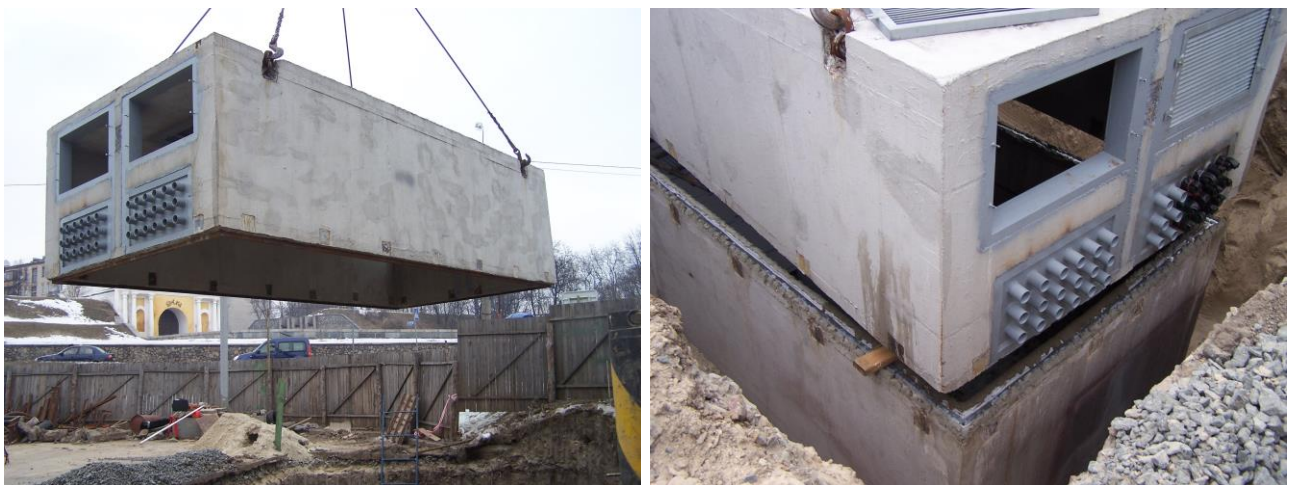
Рисунок 2.14 – Монтаж верхнього монолітного бетонного блоку
