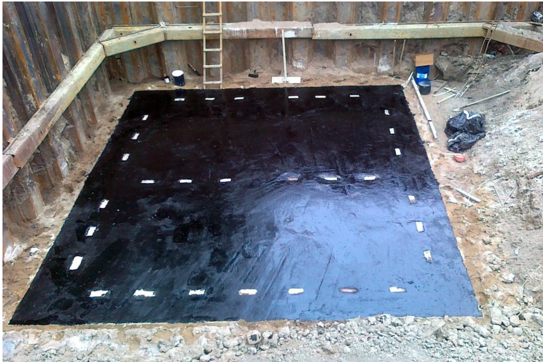
Рисунок 2.10 – Загальний вигляд підготовленого котловану
