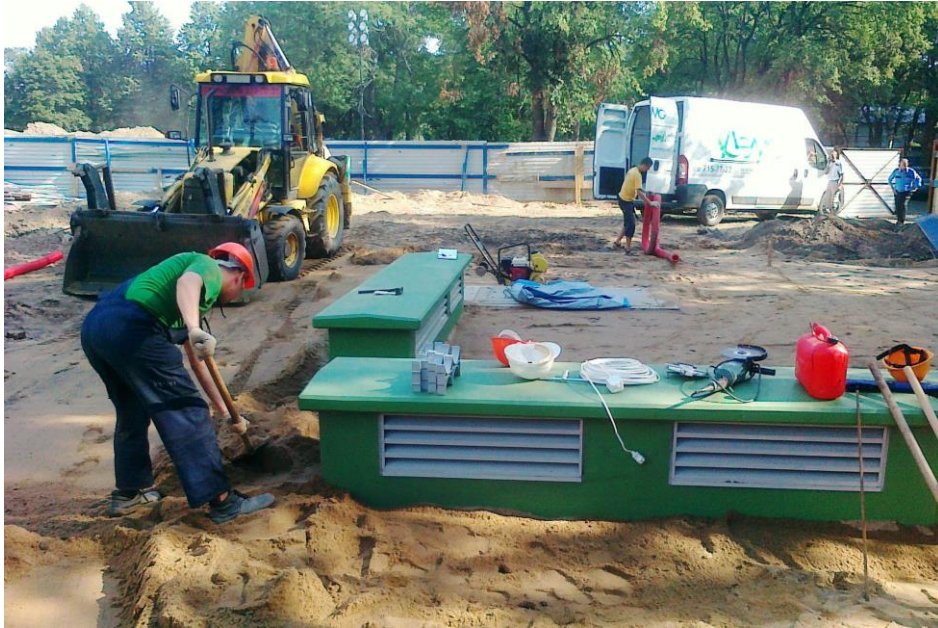
Рисунок 2.17 – Зовнішній вигляд вентиляційних шахт
