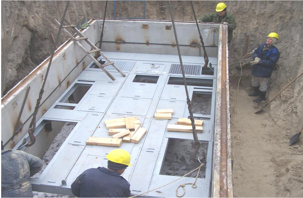
Рисунок 2.11 – Монтаж нижнього монолітного бетонного блоку
