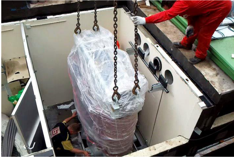
Рисунок 2.13 – Встановлення силових трансформаторів
