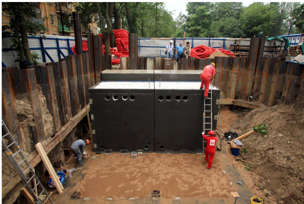
Рисунок 2.16 – Зовнішній вигляд змонтованих бетонних блоків
