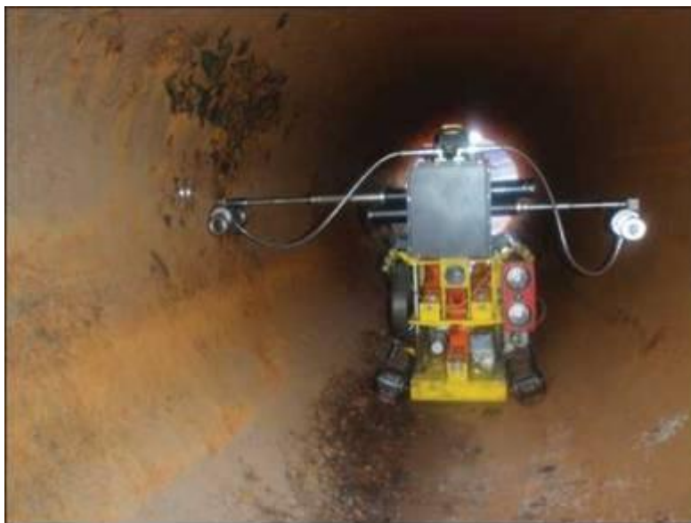
Рисунок 1.2. Робот для технічної діагностики методом ультразвукової дефектоскопії зварних швів сферичних газових резервуарів
