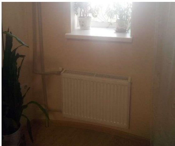
Рисунок 2.8 – Двотрубна система опалення в квартирах
