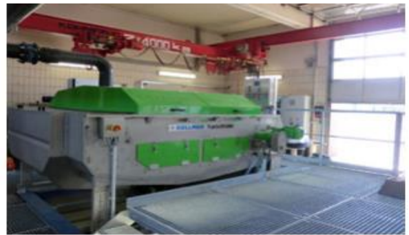
Рисунок 1.11 – Стрічковий мулоущільнювач
