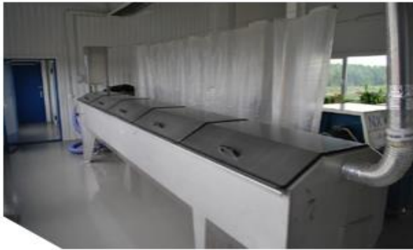
Рисунок 1.10 – Барабаний мулоущільнювач
