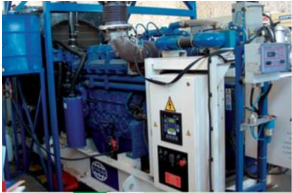
Рисунок 3.4 - Когенераційна установка HE-PG836-B
