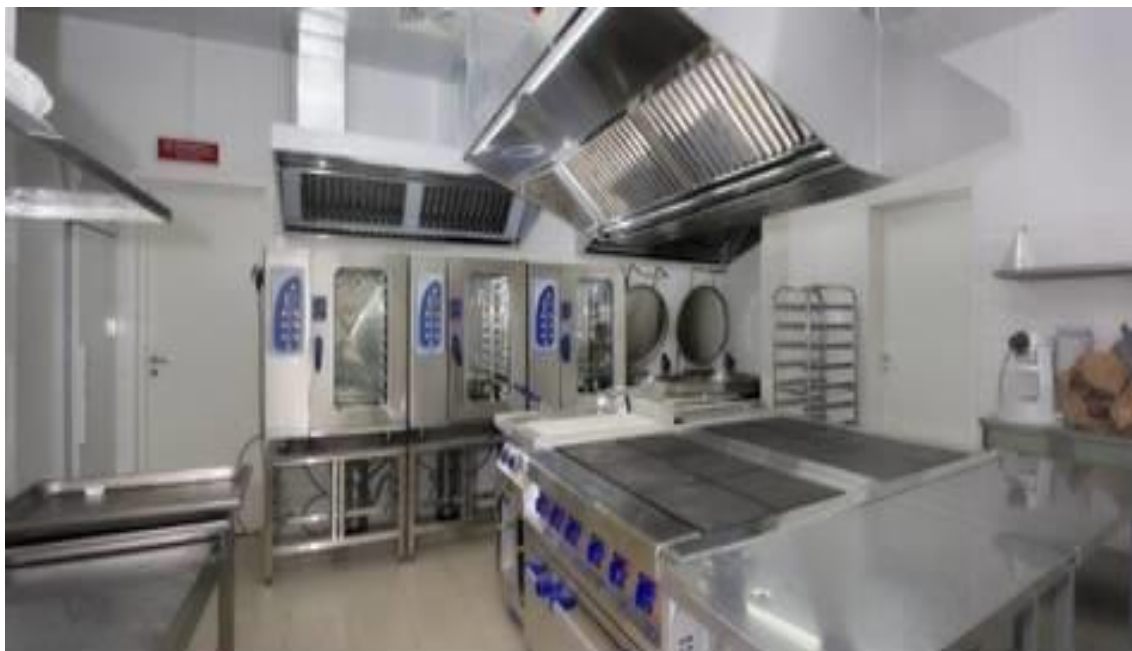
Рисунок 1.3 – Зовнішній вигляд місцевої витяжної вентиляції гарячого цеху у вигляді відсмоктувача-піддашка.
