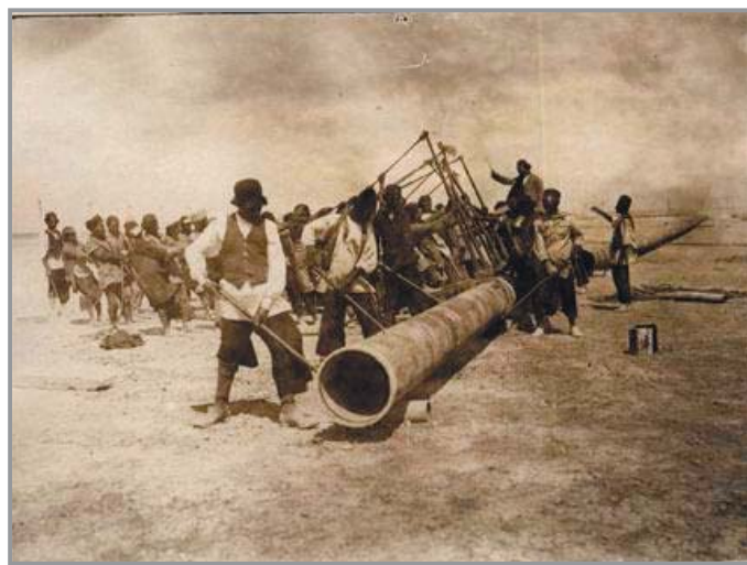
Рис. 4.3 – Доставка труб та монтаж нафтогону в південно-західній Персії (1910-ті роки)
