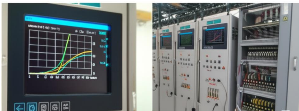
Рисунок 1.4 - Зовнішній вигляд сучасних автоматичних регуляторів напруги трансформаторів
