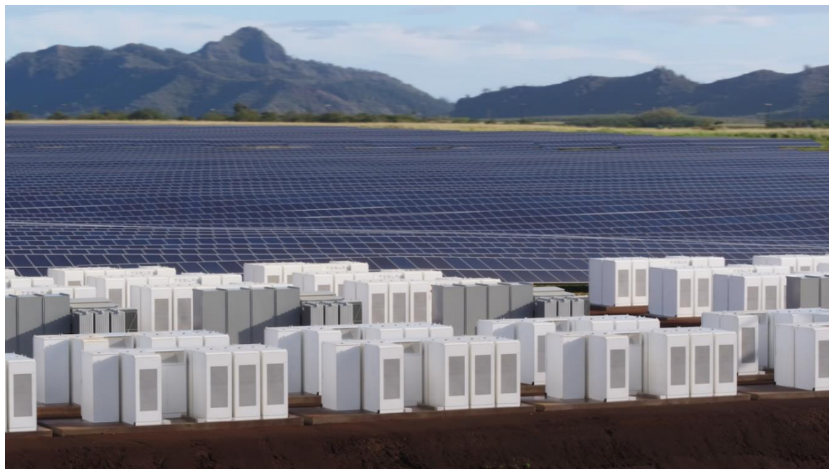
Рисунок 1.8 – Сонячна станція потужністю 13 МВт, і акумуляююча система ємністю 52 МВт·год на о.Кауаї (штат Гаваї)
