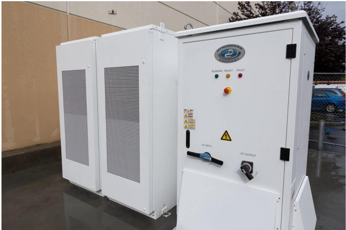
Рисунок 2.14 – Зовнішній вигляд інвертора Dynapower MPS-100
