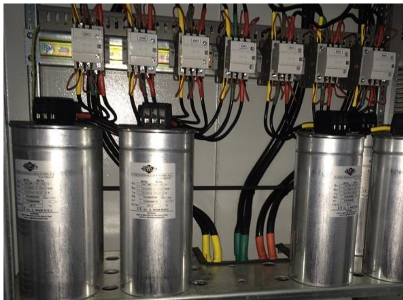
Рисунок 1.3 - Конденсаторні батареї
