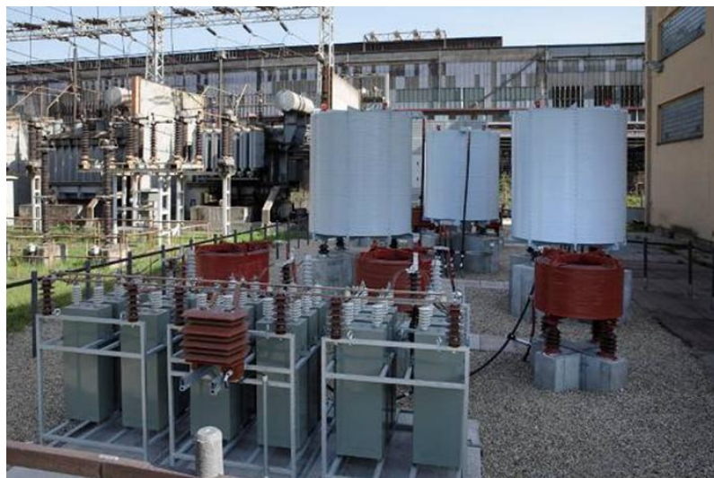
Рисунок 1.12 - Статичні тиристорні компенсатори
