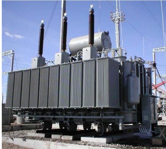
Рисунок 1.18 - Керований шунтуючий реактор
