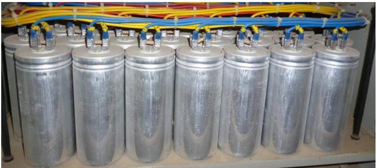
Рисунок 1.13 - Конденсаторні батареї
