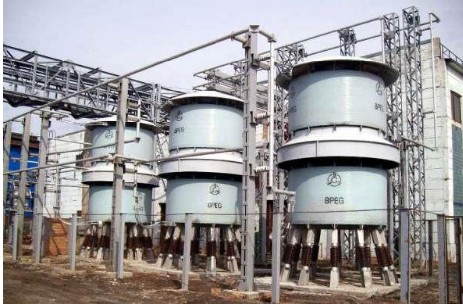
Рисунок 1.11 - Статичний тиристорний компенсатор
