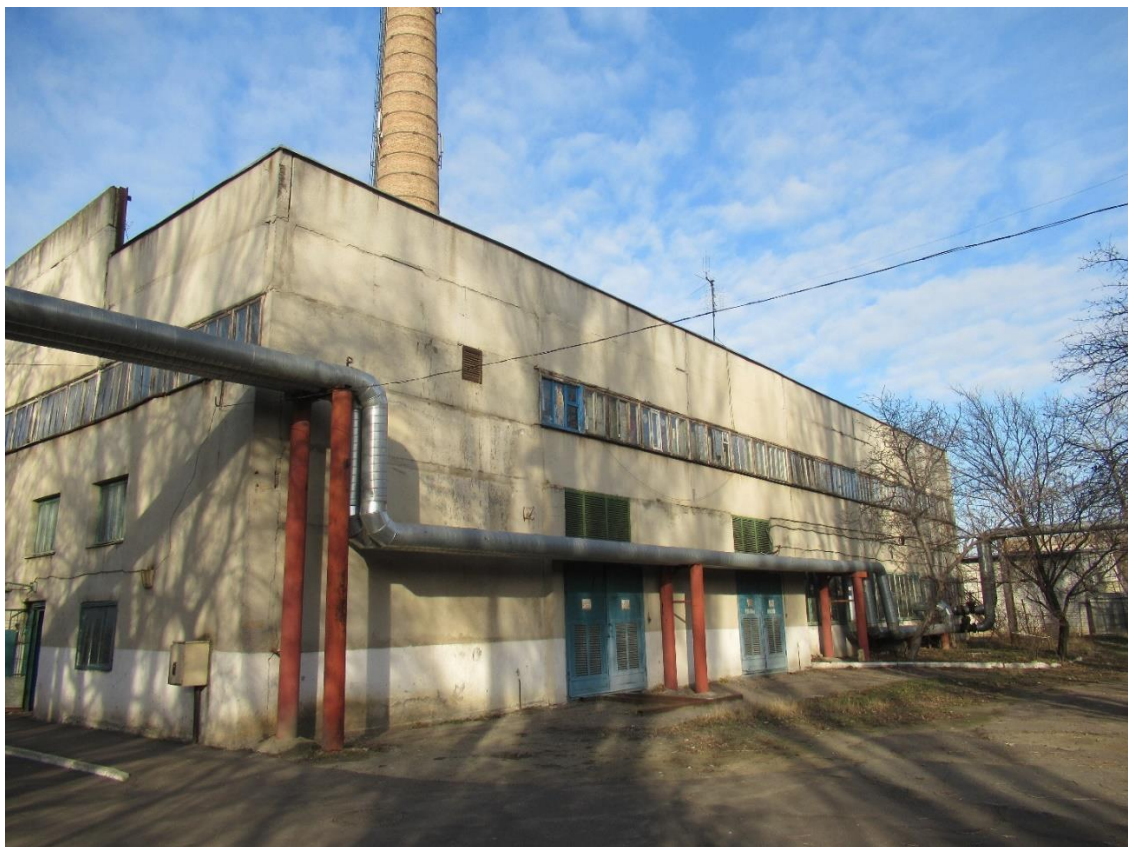
Рисунок 1.1 – Котельня, що реконструюється
