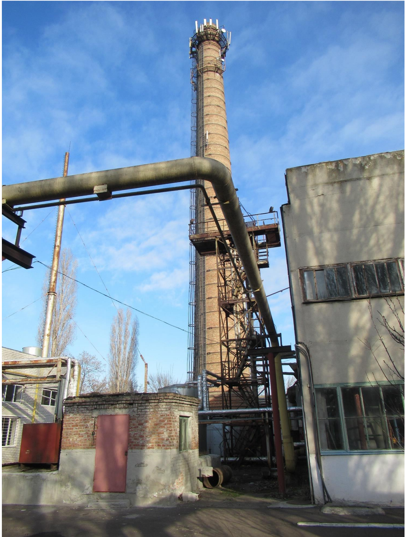
Рисунок 1.2 – Котельня що реконструюється та димова труба котельні (на передньому плані – газопровід Ду300)
