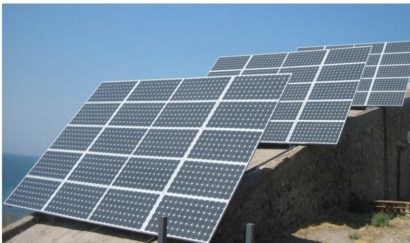
Рис. 3.9. Фотоелектрична станція потужністю 10 кВт на острові Зміїний
