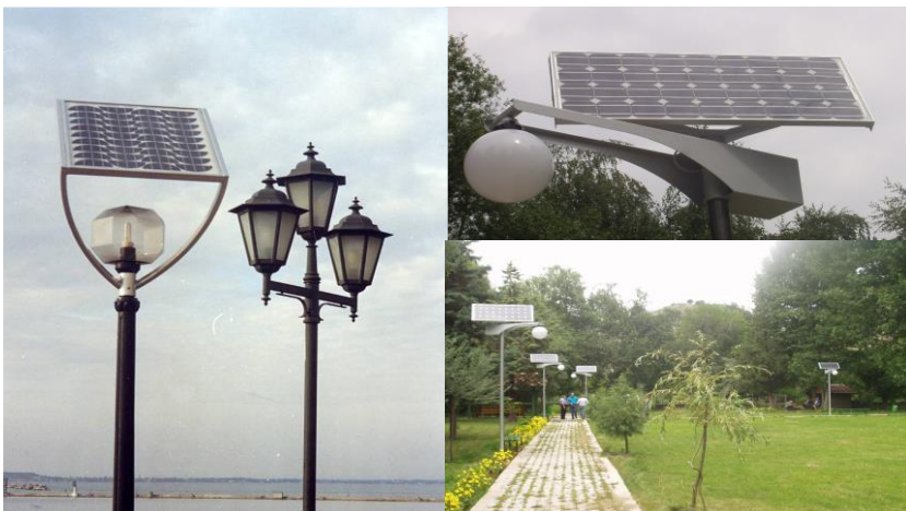
Рис. 3.8. Система фотоелектричного освітлення ботанічного саду м. Києва
