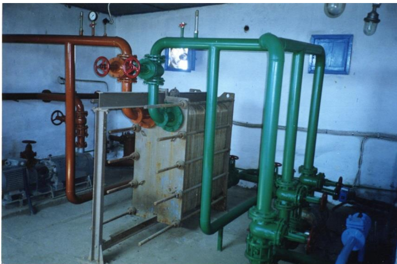
Рис. 6.8. Пластинчастий теплообмінник
